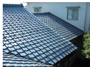
写真8 西側下屋屋根と隣家
