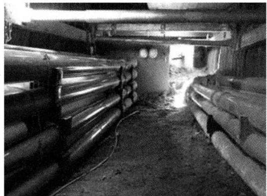
写真-13 地中化された電線類 13)
