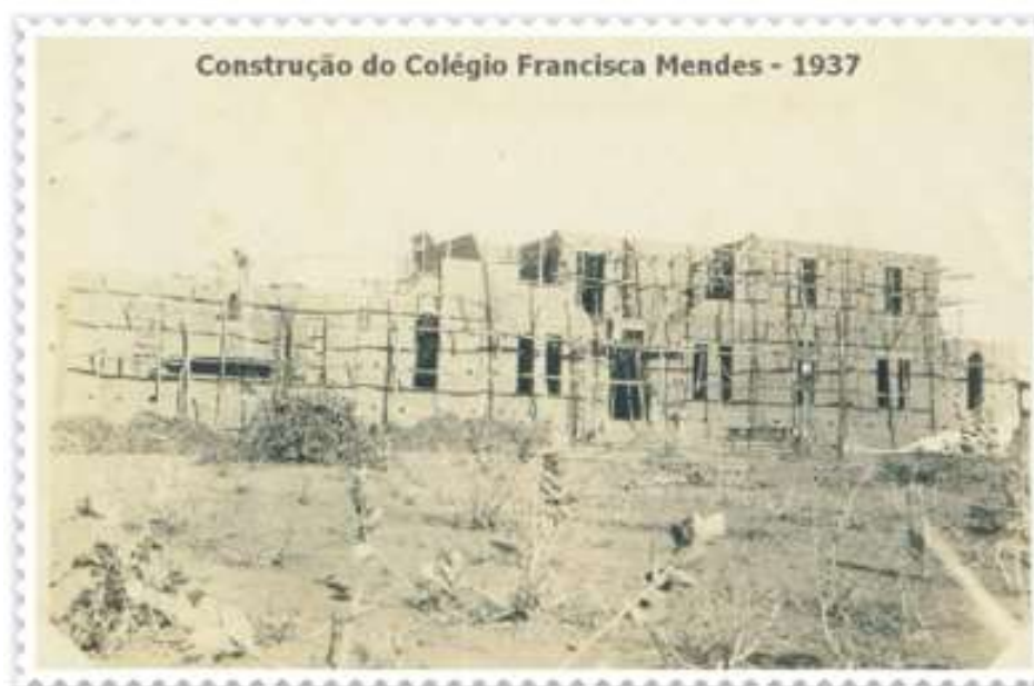
Figura 8: Construção do Colégio Normal Francisca Mendes no ano de 1937. Foto sem data. Fonte: Arquivo do CNFM
