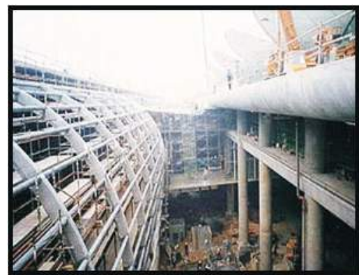
Gambar 33. konstruksi rangka baja
