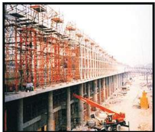
Gambar 5. Proses pembangunan Chek lap kok Airport
