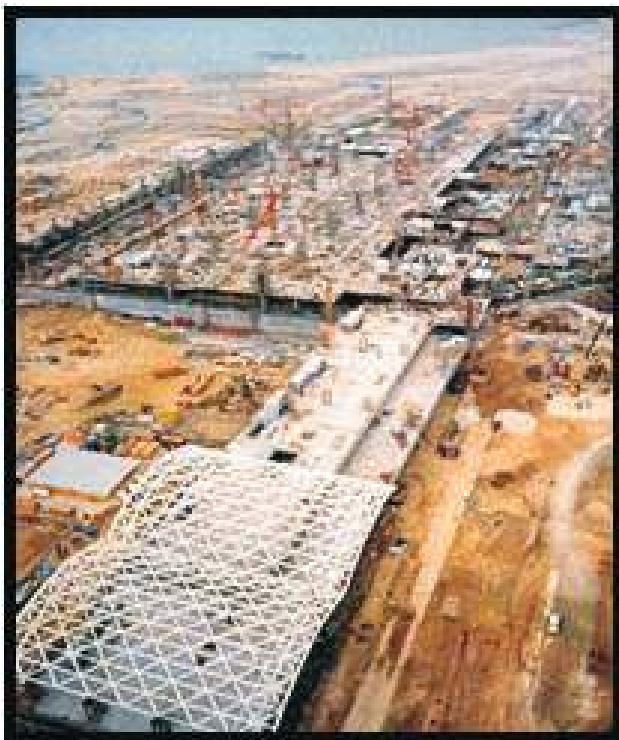
Gambar 3. Proses pembangunan Chek lap kok Airport
