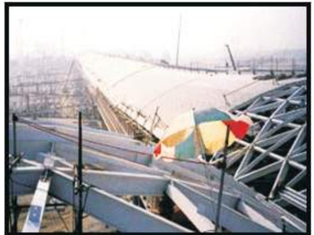
Gambar 13. atap yang sudah ditutup sebagian
