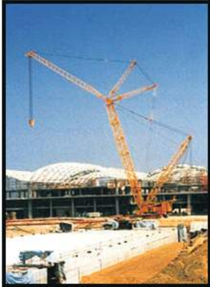
Gambar 15. alat berat jib crane untuk mengangkat modul atap
