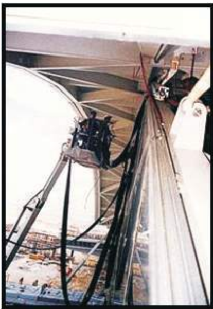
Gambar 16. pekerja menggunakan platform teleskopik
