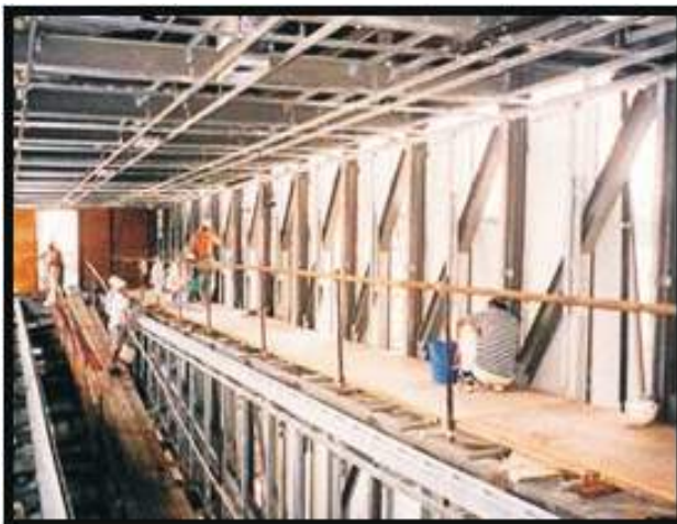
Gambar 22. rangka baja pada jembatan
