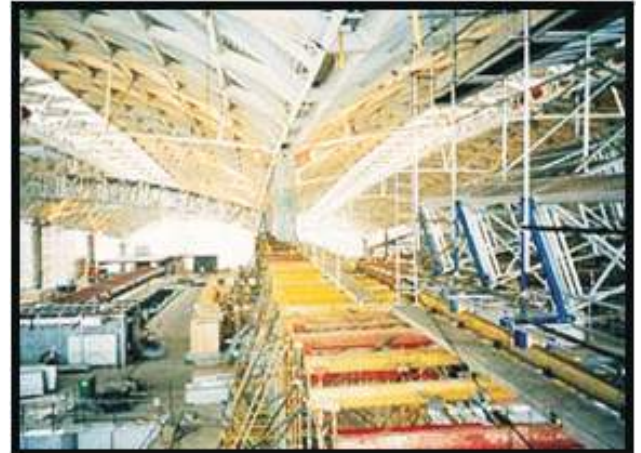
Gambar 23. konstruksi kuda kuda aluminium
