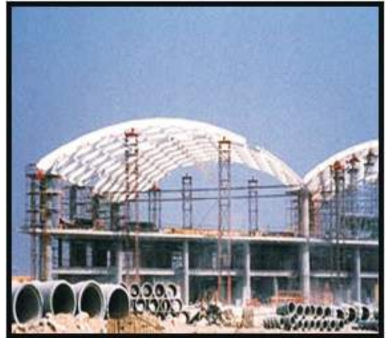
Gambar 4. Proses pembangunan Chek lap kok Airport
