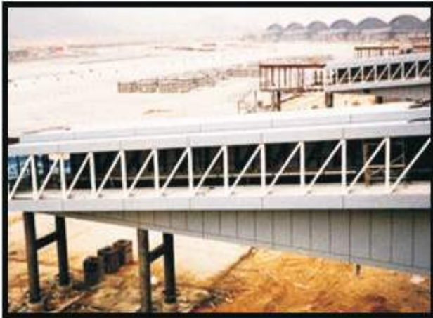
Gambar 21. jembatan sebagai penghubung
