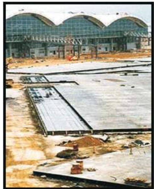
Gambar 37. Pengaspalan Untuk Daerah Apron
